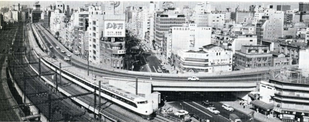
Med 210 km/t (topfart 260 km/t) skyder »shinkansen«-tog igennem Tokio-forstad. Ballast og sveller bruges nogle steder i stedet for cementstøbt banelegeme for at mindske støjplagen.
